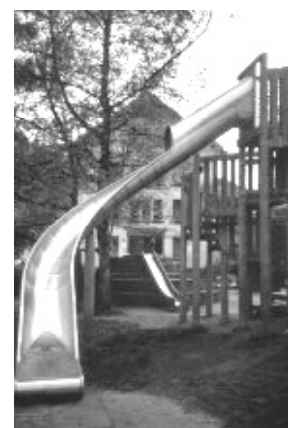
Diese Rutsche dient dem Kindergarten in Zell unter anderem als Notausgang aus dem Obergeschoss - vielleicht auch eine Lösung für das Merdingener Kindergartenobergeschoss?
